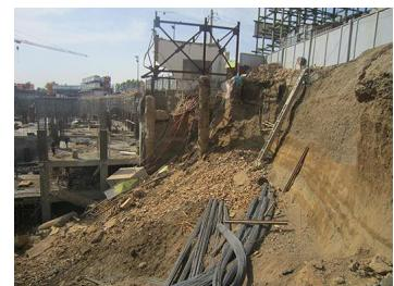
ریزش دیوار ملک گودبرداری شده منجر به سقوط تیر چراغ برق گردید.
